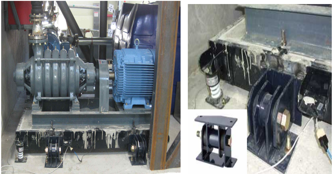
이동방지형 내진 스토퍼 설치 사례
